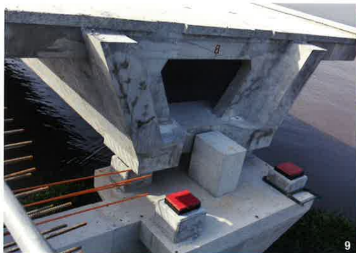
9- Appuis provisoires. 10- Aire de péage.
